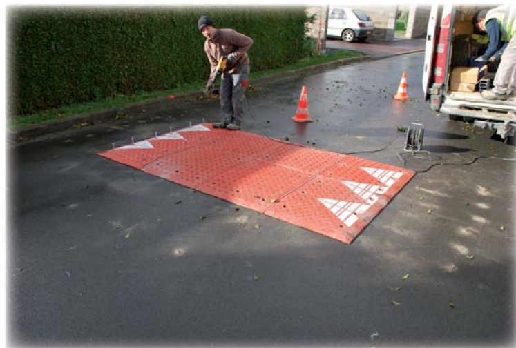
Pose des coussins berlinois rue des Costils par la société AD Equipements
